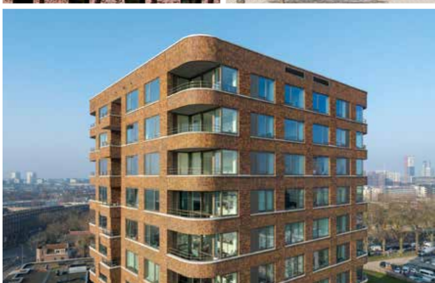
Gebruik van baksteen om aan te sluiten bij De Muntel
